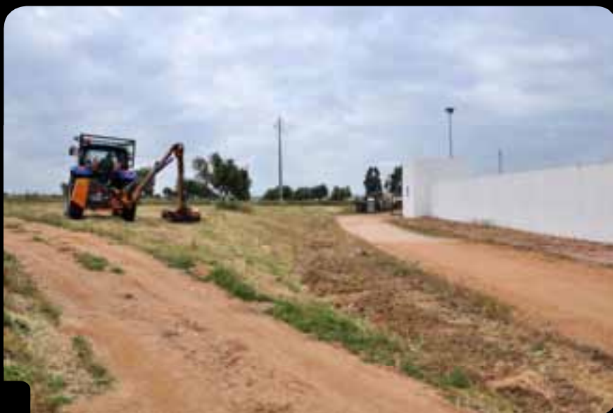
Limpeza de pasto em Vaiamonte
