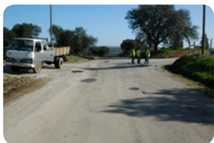
> Conservação do pavimento da estrada entre Vaiamonte e o IP2
