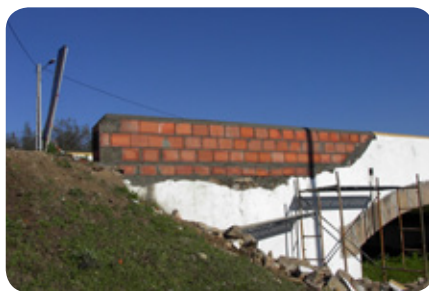
> Reparação da Ponte de Vaiamonte
