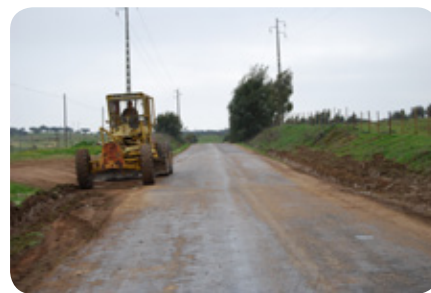
> Limpeza de Bermas e Valetas (Santo Aleixo/Borba)
