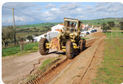
> Conservação do acesso às Casas Altas em Santo Aleixo
