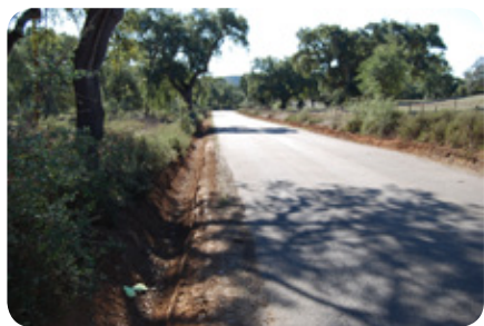
> Limpeza de Bermas e Valetas (Vaiamonte/IP2)
