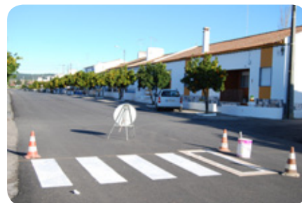
> Pintura de Passadeiras - Vaiamonte
